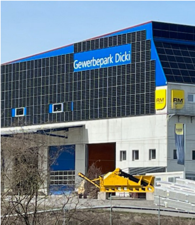
Fassade Industriebau in Hasle-Rüegsau (2024). Foto: SpiezSolar
