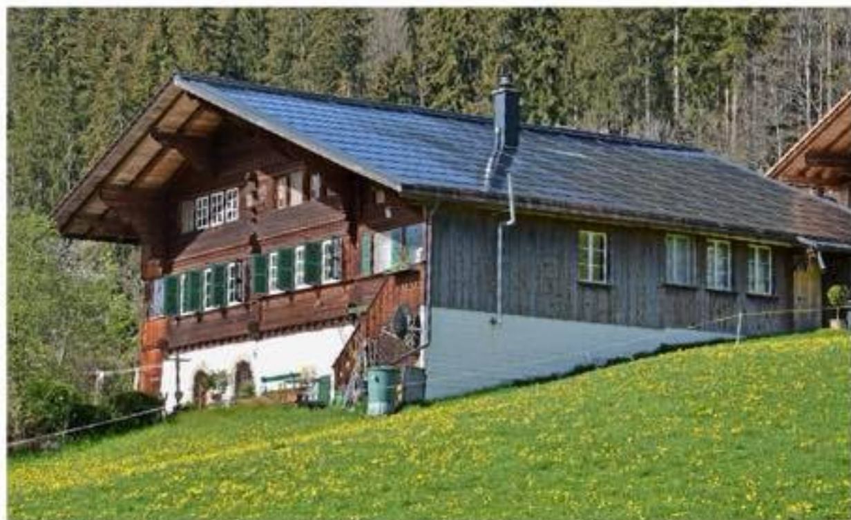
Die Fotovoltaikanlage liefert erneuerbare Energie vom Dach des 300-jährigen Bauernhauses am Obersimmentaler Hausweg. Foto: Fritz Leuzinger
