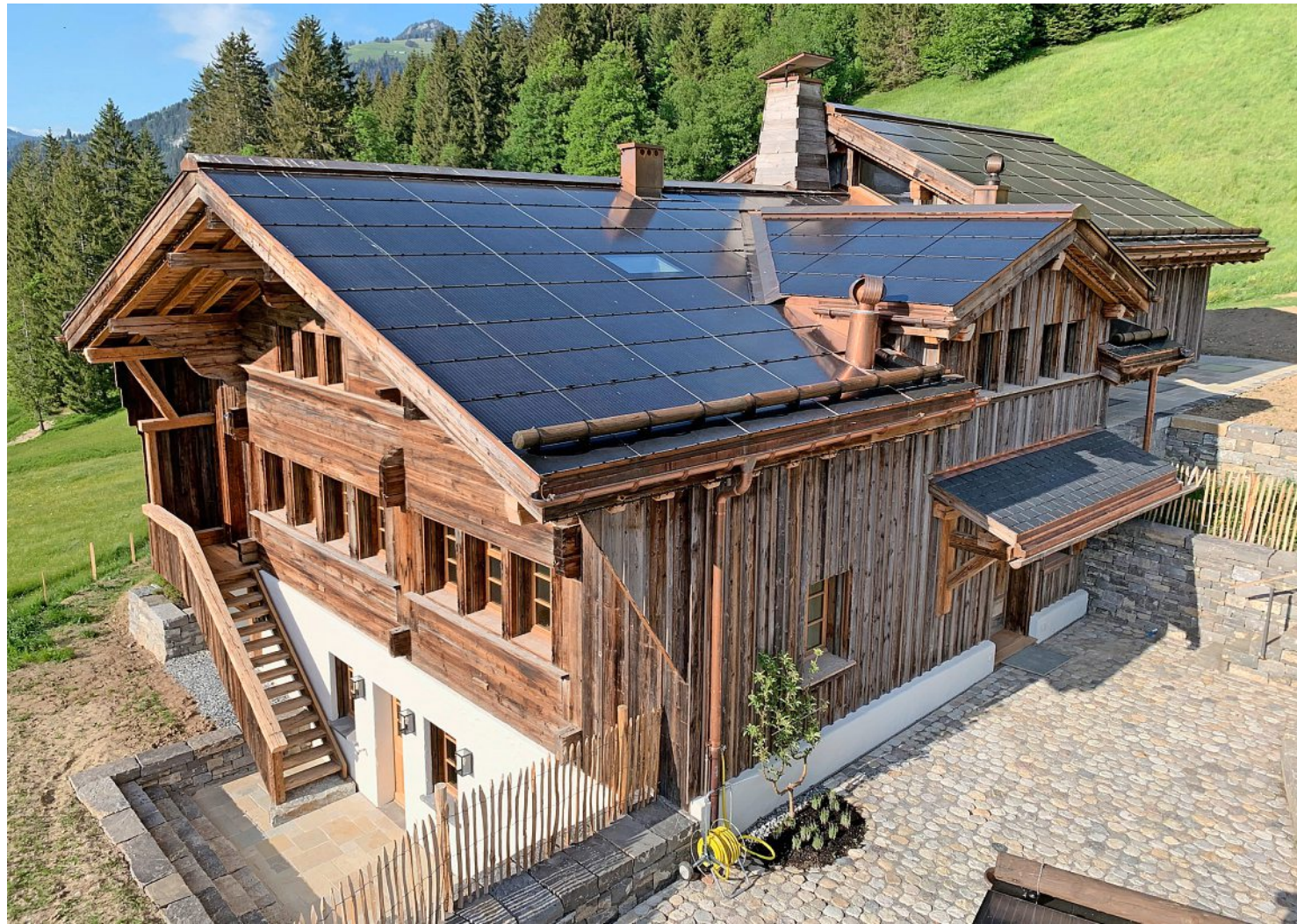
Solarmodule, Spezialglas und Dachfenster, alles made in Berner Oberland. Eine Indach-Solaranlage, erbaut von der Firma Solar-Up. Foto: PD
