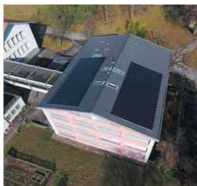
... auf dem Gebäude C (und B) des Schulzentrums Längenstein
