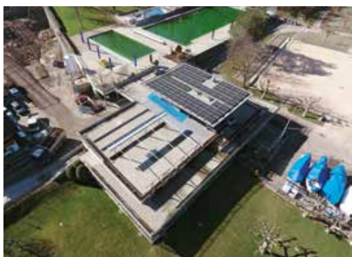
Solarzellen auf dem Restaurant-Dach des Frei- und Seebads...
