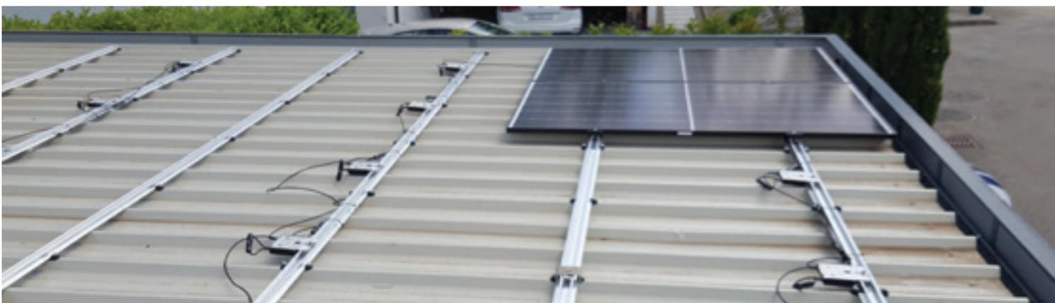
PV-Anlage auf Carport aus Trapezblech: die Schienen werden direkt mit dem Blech verschraubt
