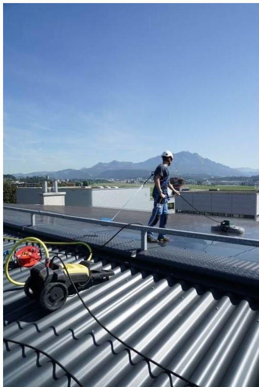
Abbildung 10: Reinigung Solaranlage, BE Netz AG
