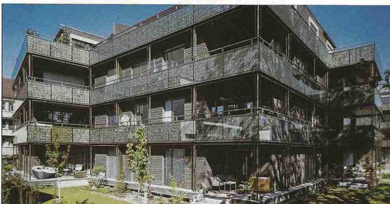
Fotovoltaik-Anlage als Balkongeländer in Zürich – ein Projekt von Beat Kämpfen.
