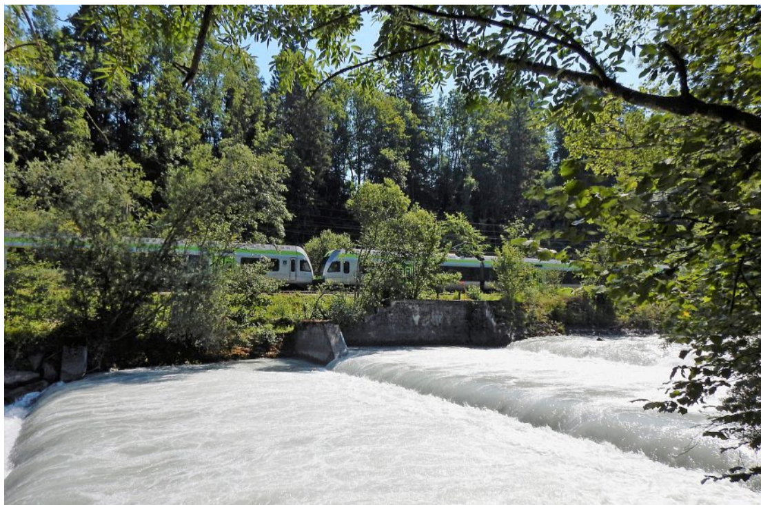
Drei Schwellen beim Rossweidli vermitteln die Kraft des Wassers, mit welcher elektrische Energie für 7700 Haushalte pro Jahr produziert wird. Im Hintergrund die BLS-Strecke Spiez-Frutigen. Foto: Guido Lauper
