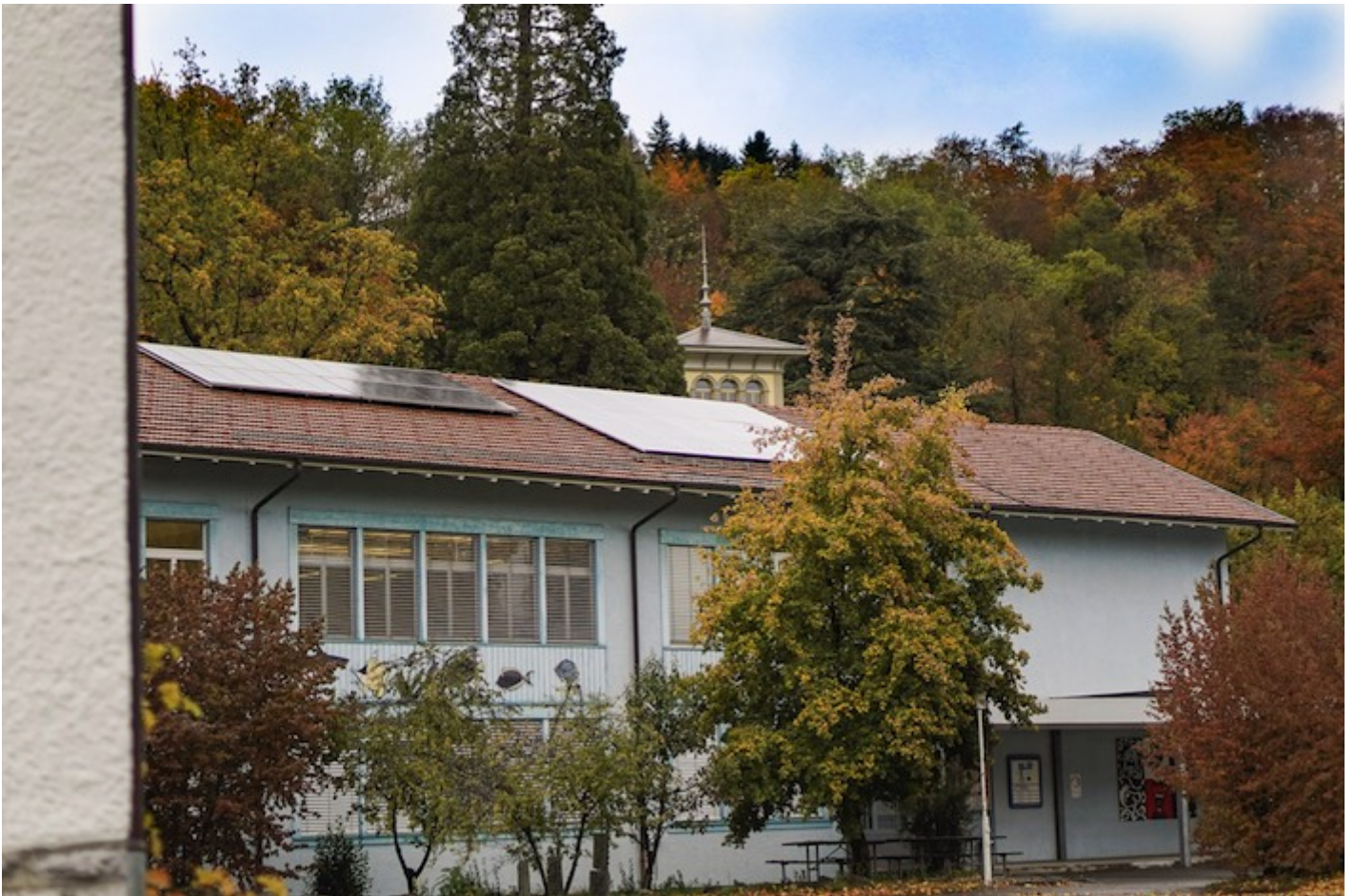
Bereits 1999 installierte SpiezSolar auf dem Dach des Schulhauses Längenstein in Spiez eine Solaranlage.
