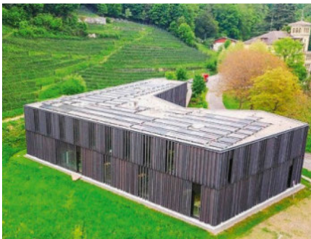
Finanziert von der Bevölkerung: die Photovoltaikanlage auf der Bibliothek. Bild: zvg
