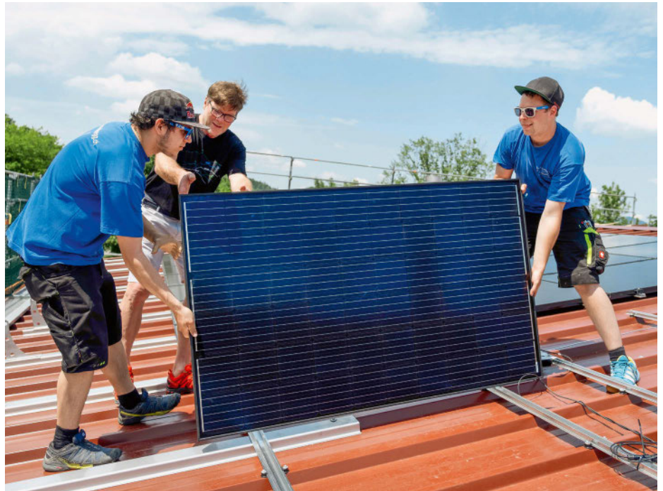
Das Dach des Werkhofs wird mit rund 190 m 2 Photovoltaikzellen mit einer Leistung von 33,5 kWp. Der Präsident von SpiezSolar packt mit an.
