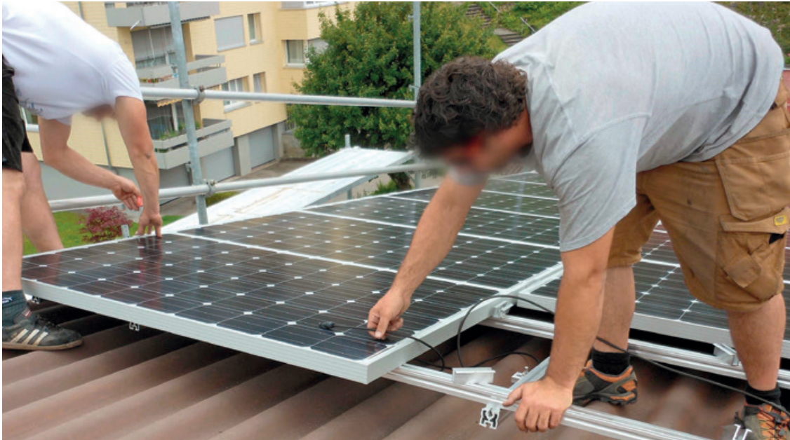
Monteure installieren eine Photovoltaikanlage.
